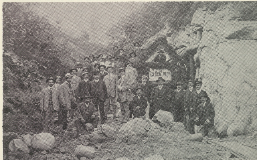
Predstavnici firme »Rumpel«, čiji su radnici izvodili radove na izgradnji prvog vodovoda. Detalj je sa završetka radova na tunelu za cjevovod — Mosnik
