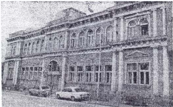
Konačno temeljita adaptacija – zgrada Narodne biblioteke
